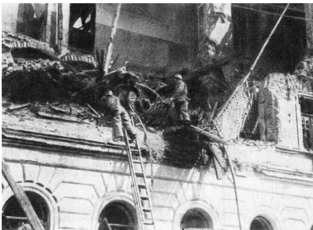
Спасание пожарными людей из разрушенного здания
